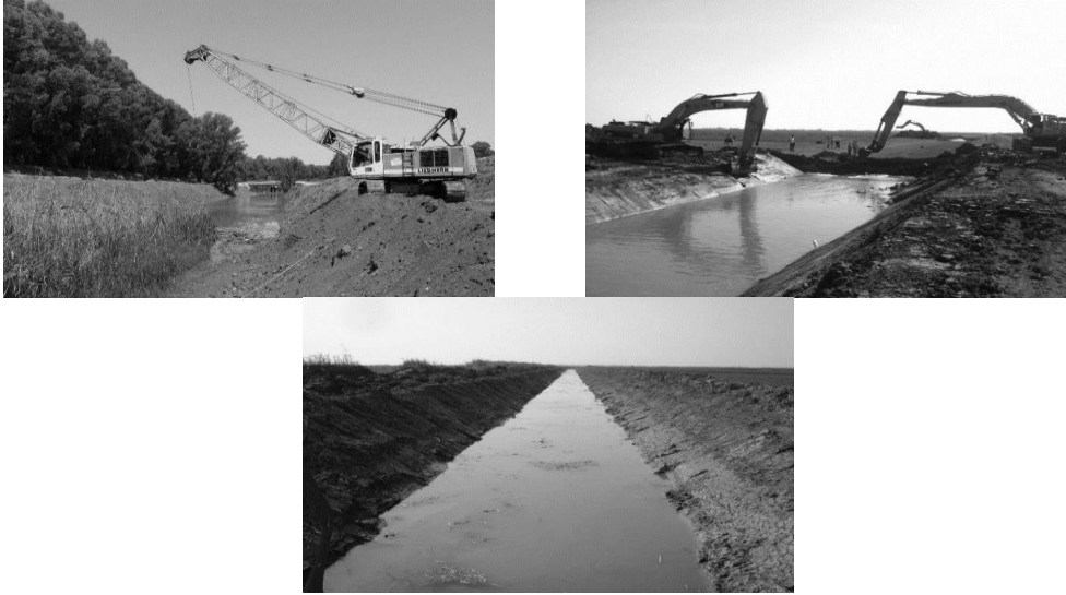
صورة رقم 01: أشغال تنقية قنوات التصريف بسهل الغرب سنة 2011
